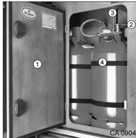
Fig. 50 Coffre à gaz
