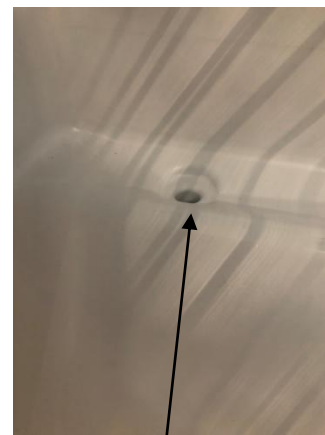
Trou d'évacuation vers le bac de récupération
