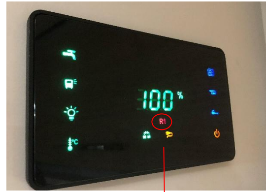
Témoin du réservoir des eaux usées
