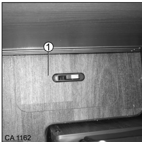
Fig. 133 Emplacement du robinet d'arrêt de l'échangeur thermique Iveco
