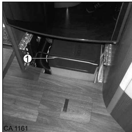
Fig. 129 Emplacement du chauffage
