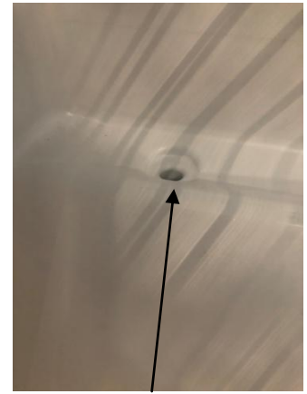
Trou d'évacuation vers le bac de récupération
