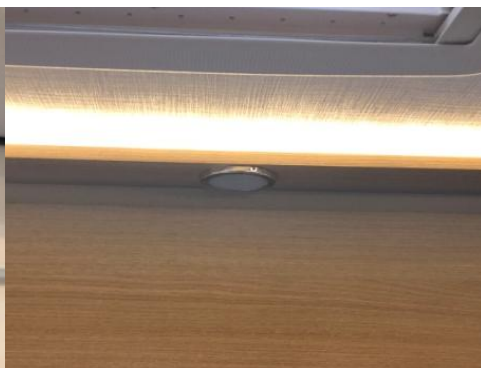
Spot LED + Bande lumineuse sur placards
