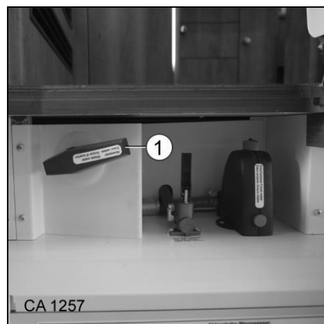
Fig. 141 Vidange du réservoir des eaux usées
