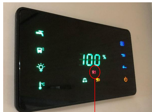
Témoin du réservoir des eaux usées
